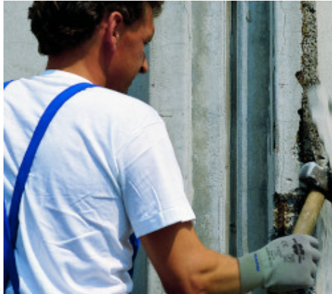
Abbruch von geschädigtem Beton
