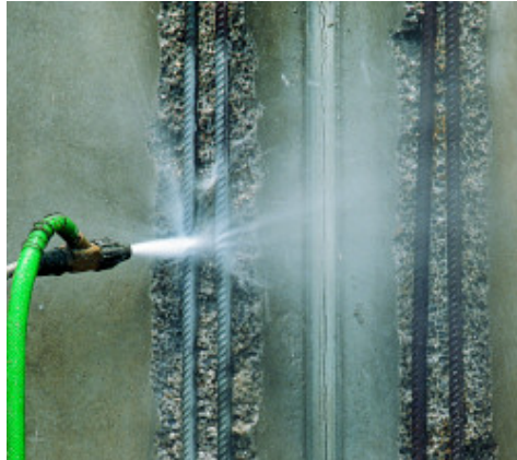
Reinigung der Bewehrung
